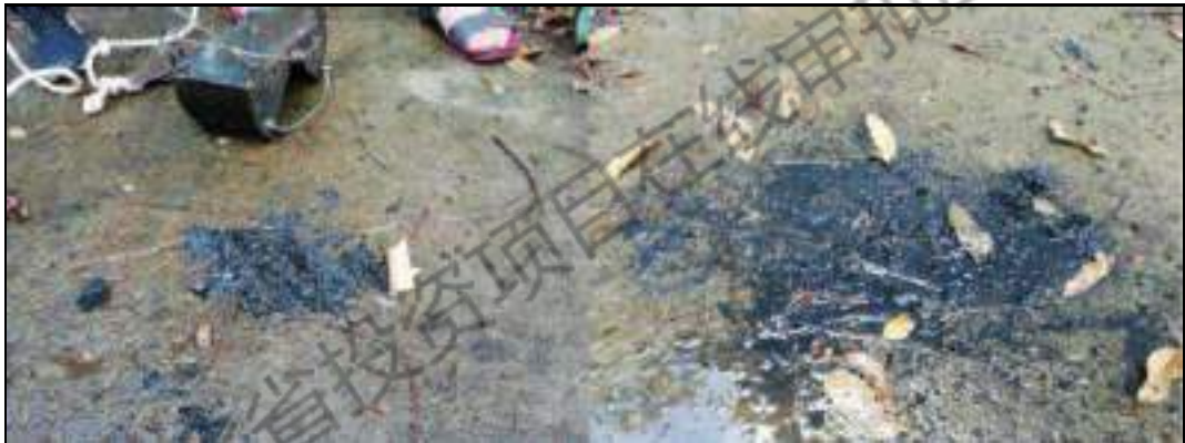
图 4 严东湖西渠底泥现状
