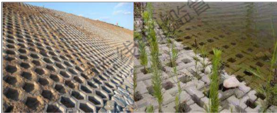
图10 生态连锁块护坡示意图
